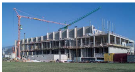
Vopred zabetónované nosníky zvyšujú efektívnosť a bezpečnosť na stavbe.
