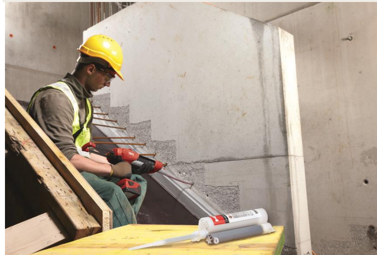
Dodatečné napojování schodiště na stěnu
