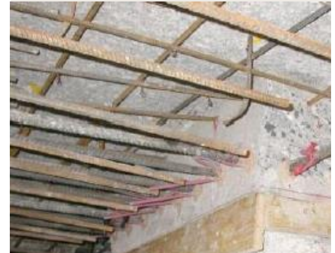
Dodatečné spojování desek se sloupy
