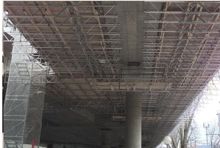
Zesilování betonu, např. mosty
