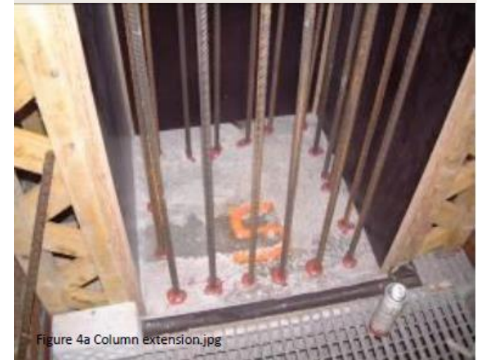
Dodatečné vlepování výztuže u pokračování sloupů
