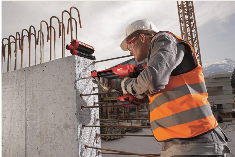
Dodatečné vlepování výztuže pro pokračování stěn
