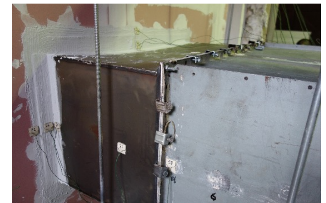
Pohled na detail těsnění prostupu VZT potrubí s požární klapkou z druhé strany, tedy na neohřívanou straně (vně pece)
